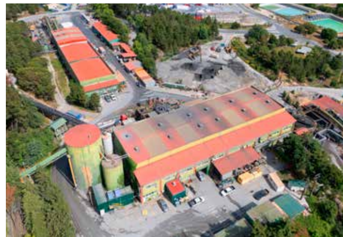
Το εργοστάσιο εμπλουτισμού στην Ολυμπιάδα
