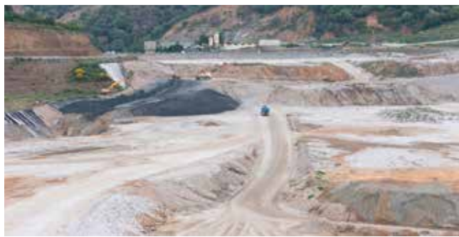
Ο χώρος Ξηρής απόθεσης μεταλλευτικών καταλοίπων στον Κοκκινόλακκα
